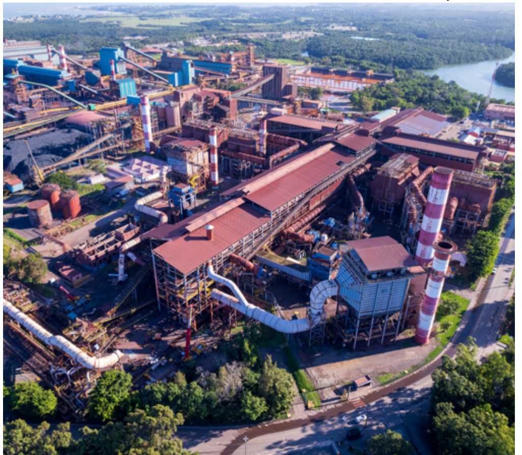
USINAS de Pelotização 1 e 2 na Unidade da Samarco em Ubu, Anchieta (ES)
