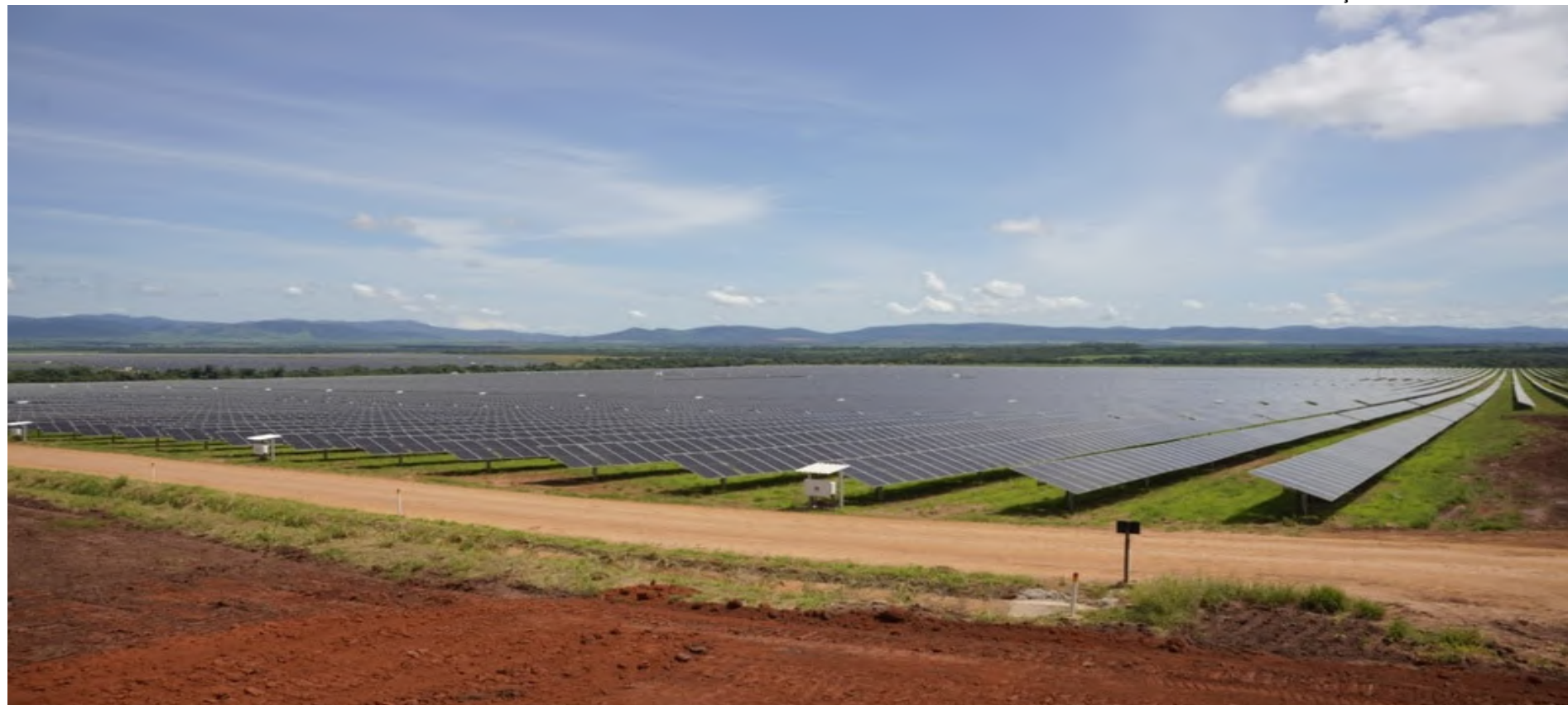
VISTA do Complexo Solar de Barro Alto (GO)
