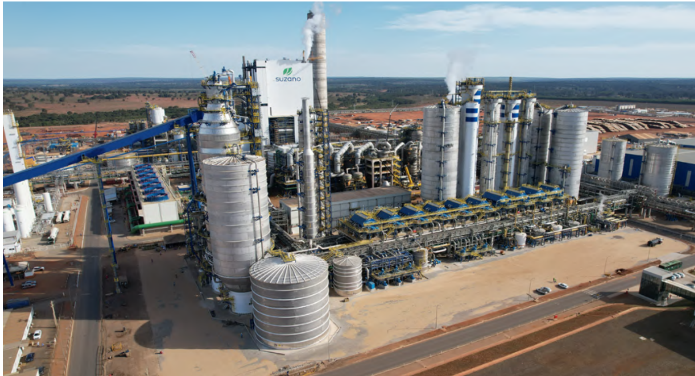
VISTA AÉREA da Suzano Unidade Ribas do Rio Pardo (MS)
