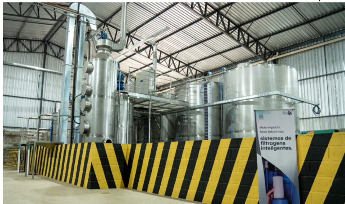
O PROCESSO químico transforma o plástico em resina biodegradável aplicada em pilhas de minério
