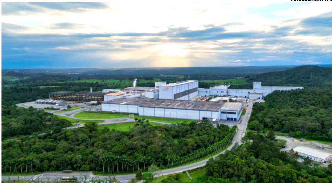
UNIDADE da ArcelorMittal em São Francisco do Sul (SC)
