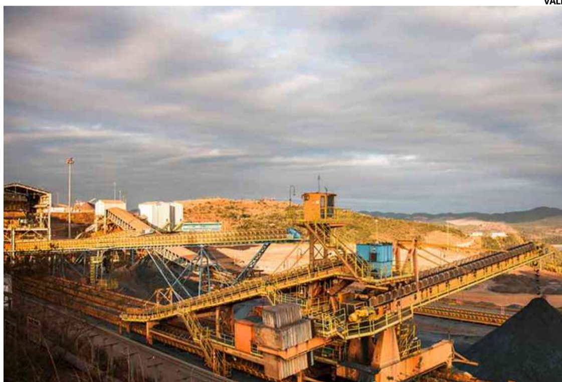
PILHAS de minério no pátio de produtos em Brucutu (MG)
