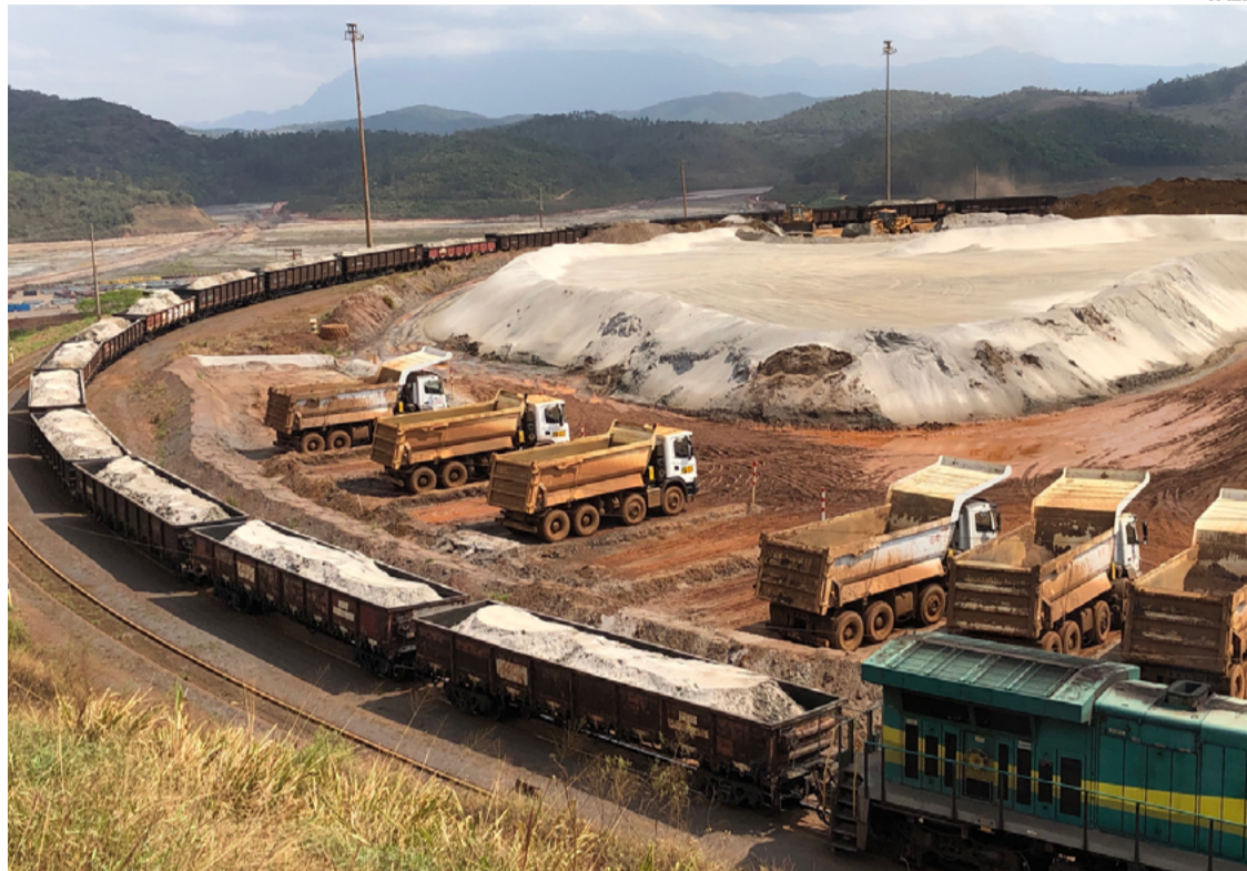
PÁTIO DE ESTOCAGEM na mina de Brucutu, em MG
