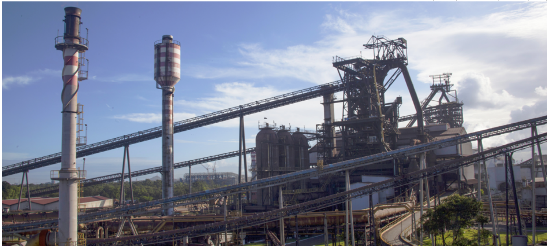
ALTO FORNO 3: equipamento agora funciona à gás natural
